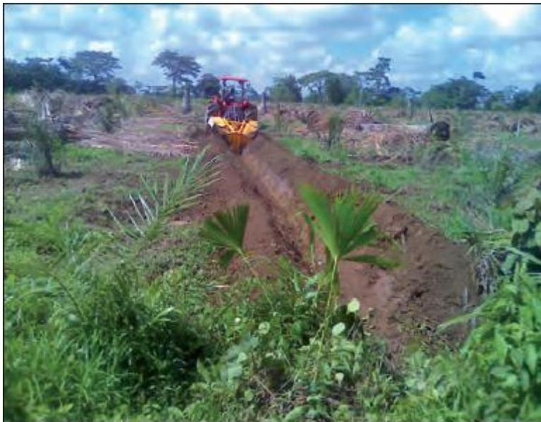
Figura 21. Canales interlineales construidos con zanjadora rotativa (foto Jesús López).
